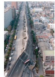
阪神淡路大震災 阪神高速道路
